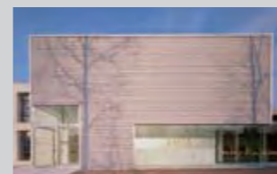
Ingresso uffici AMIA Verona 2004 Carlo Ferrari, Alberto Pontiroli / Archingegno
