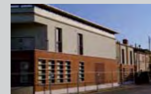
Edificio residenziale Buttapietra 2008 Fabio Faoro, Nicola Preti / Viabrenneroarchitettura
